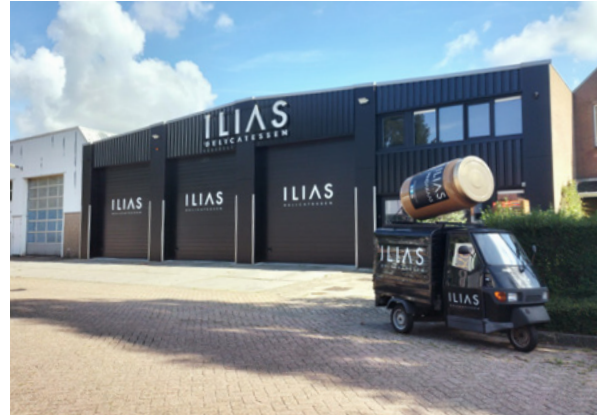
Recente opwaardering gevel zorgt voor aantrekkelijkere gevelbeeld
