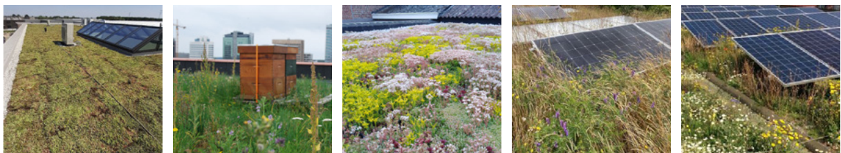
Palet dak: lage daken mos-sedum/vegetatiedak (jvt. icm zonnepanelen), hoge daken zonnepanelen
